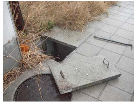
Arqueta Telefónica Tipo H
