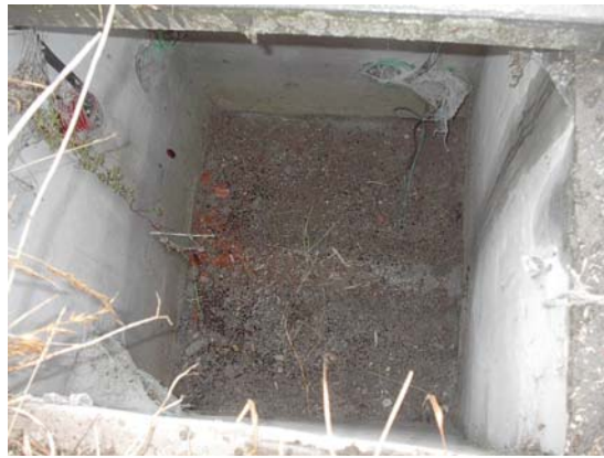
Arqueta Telefónica Tipo H
