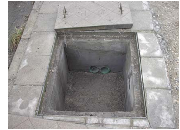
Arqueta Telefónica Tipo H
